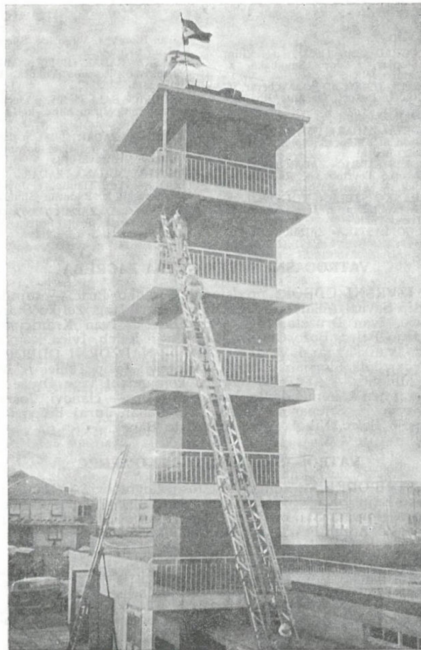
ZADAR (1968): Novi vatrogasni toranj građen je po najsuvremenijim vatrogasnim kriterijima, te funkcionalno služi za vježbe i osmatranje
